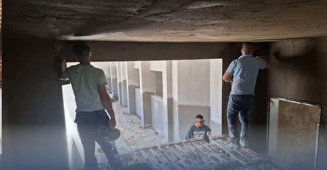
Chantier de l'école Palestine à Dura
